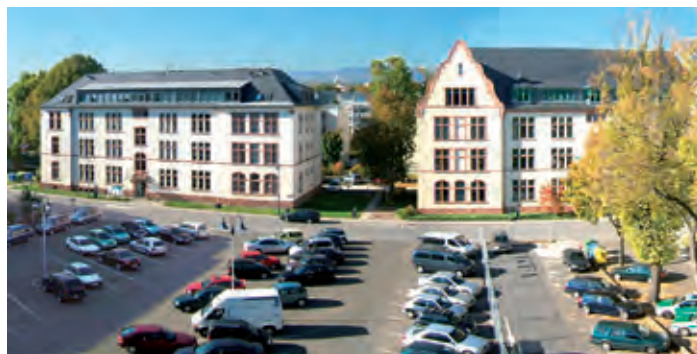
Haus A, Alcide-de-Gasperi-Straße 4
