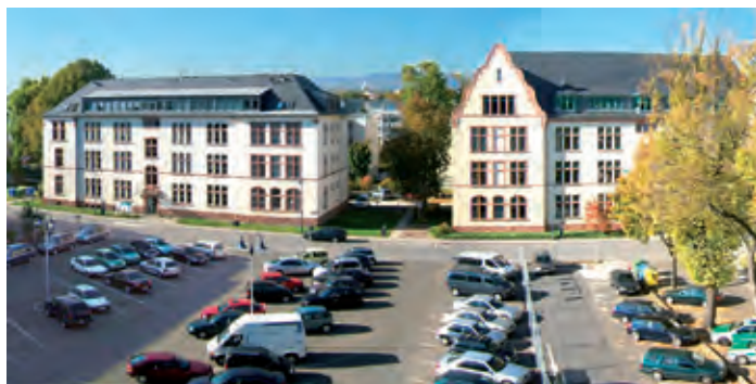
Haus A, Alcide-de-Gasperi-Straße 4
